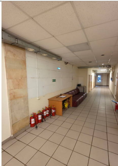
Место монтажа шкафа
