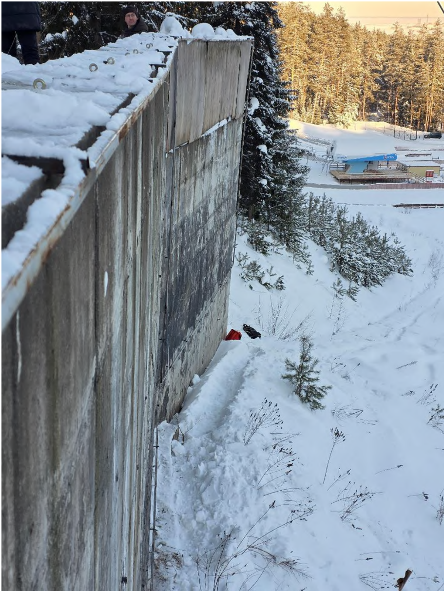
Фото 5. Фрагмент подпорной стены в осях 3-2, 2-1.
