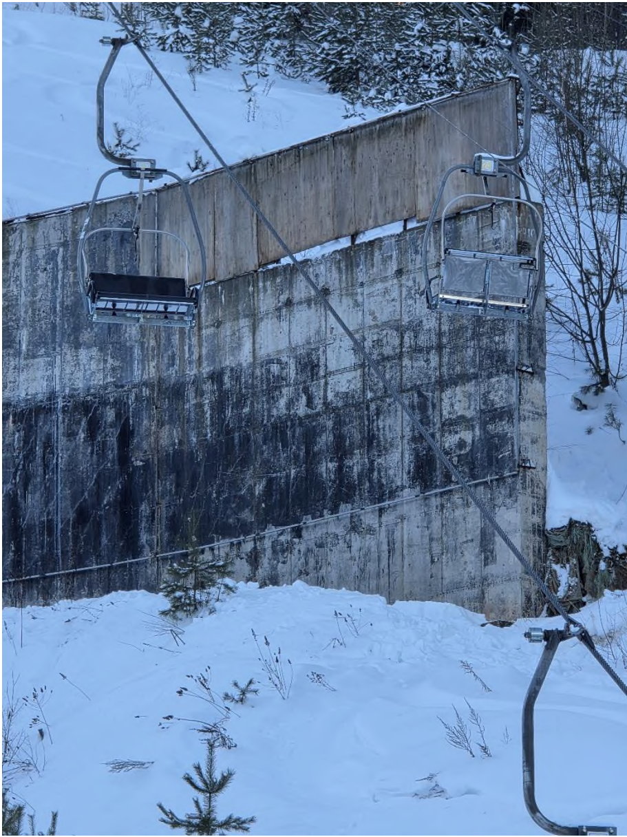
Фото 3. Подпорная стена в осях 2-1. Общий вид.
