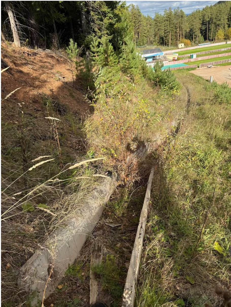
Фото 27. Водоотводящий железобетонный лоток рядом с подпорной стеной по оси 1. Фотография предоставлена заказчиком.
