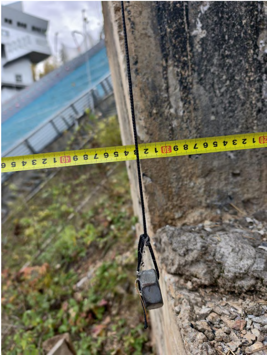
Фото 16. Отклонение центральной части стены (в осях 2-3) от вертикали на величину до 33-х см. Фотография предоставлена заказчиком.
