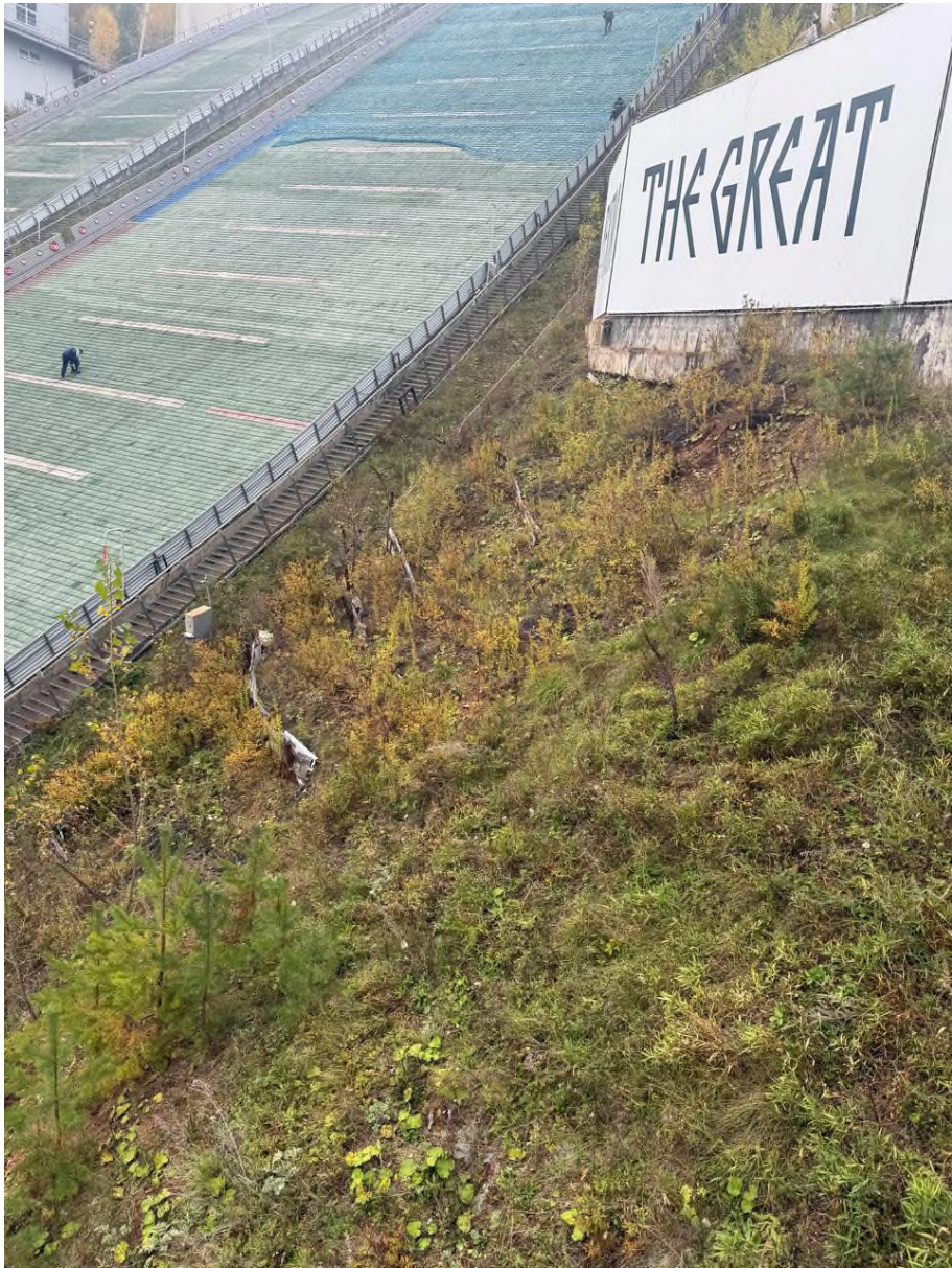
Фото 26. Самодельные грунтозадерживающие конструкции напротив центральной части подпорной стены в осях 2-3. Фотография предоставлена заказчиком.
