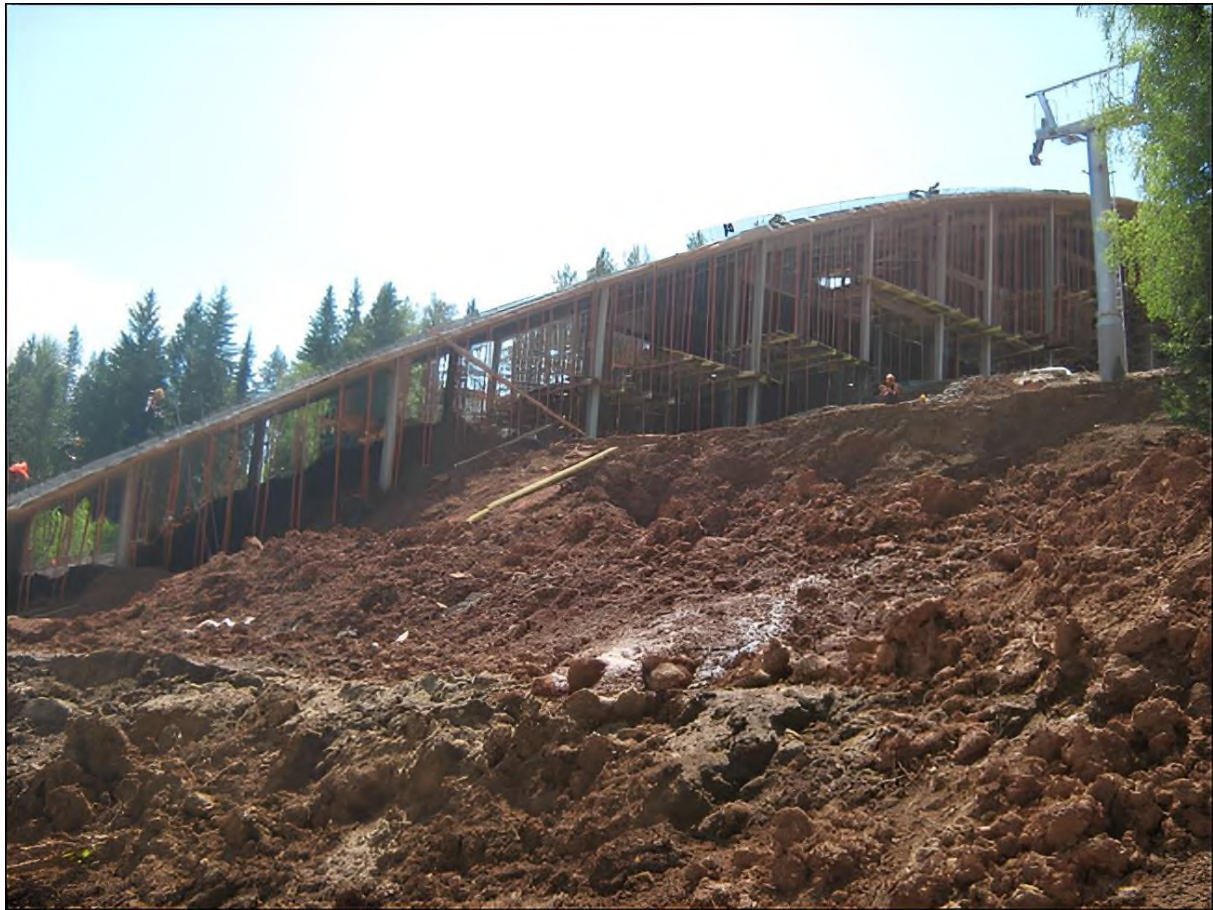
Фото 28. Насыпной грунт в месте устройства подпорной стены. Фотография предоставлена заказчиком.
