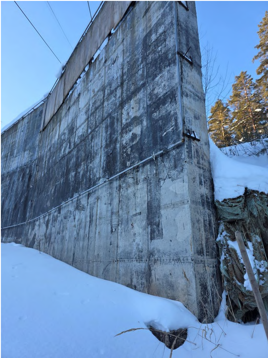
Фото 4. Подпорная стены в осях 2-1. Общий вид.
