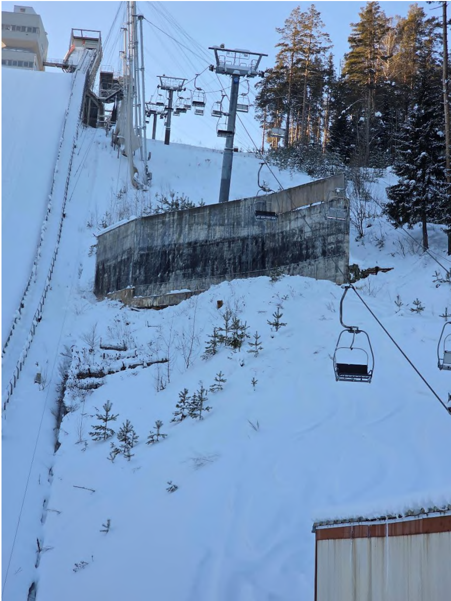
Фото 1. Железобетонная подпорная стена. Общий вид.
